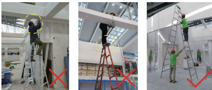
正确的登高作业：2人，1人登高、1人看护，不得站立在梯子最顶层作业，不得使用劣质人字梯。
